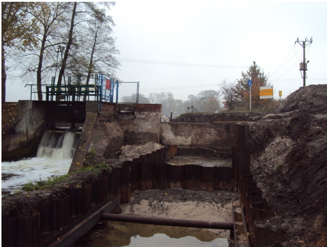
Lisi Ogon – zakończono wbijanie ścianki szczelnej przystąpiono do prac betoniarskich
