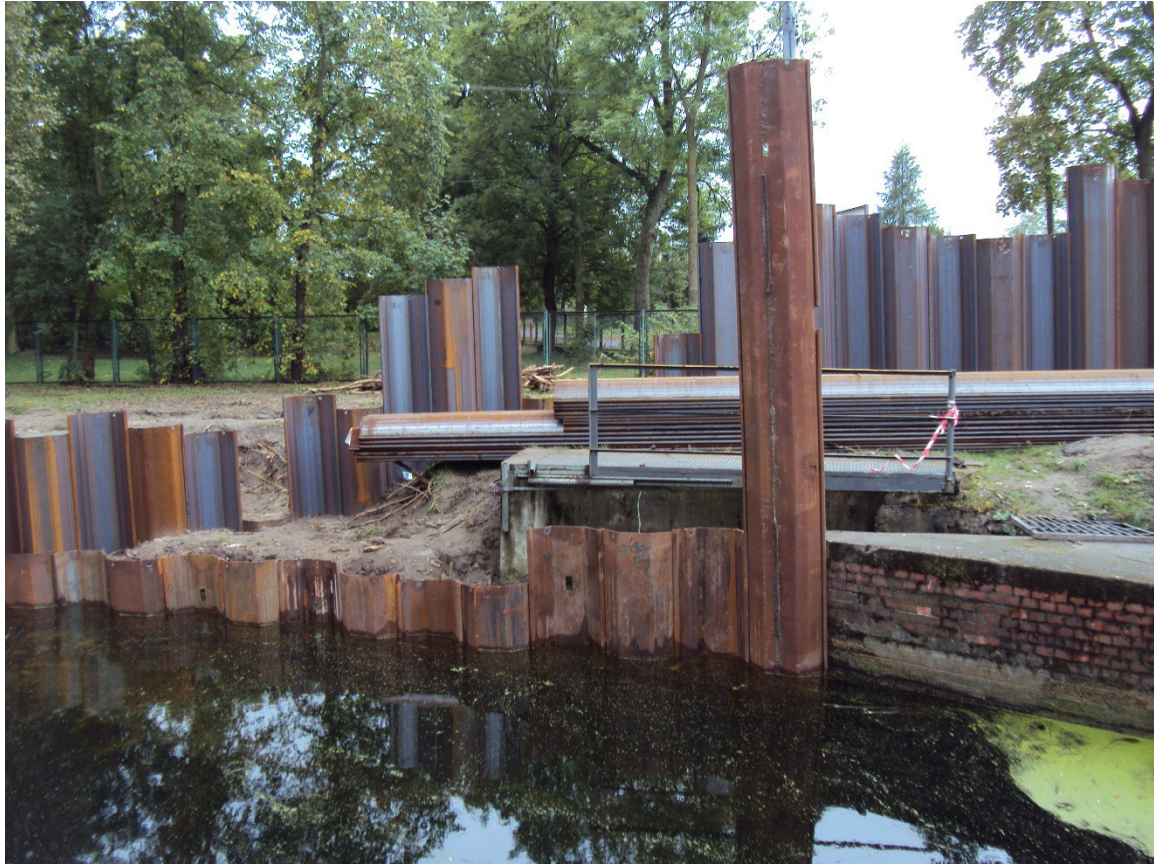
Łochowo zakończono wbijanie ścianki szczelnej
