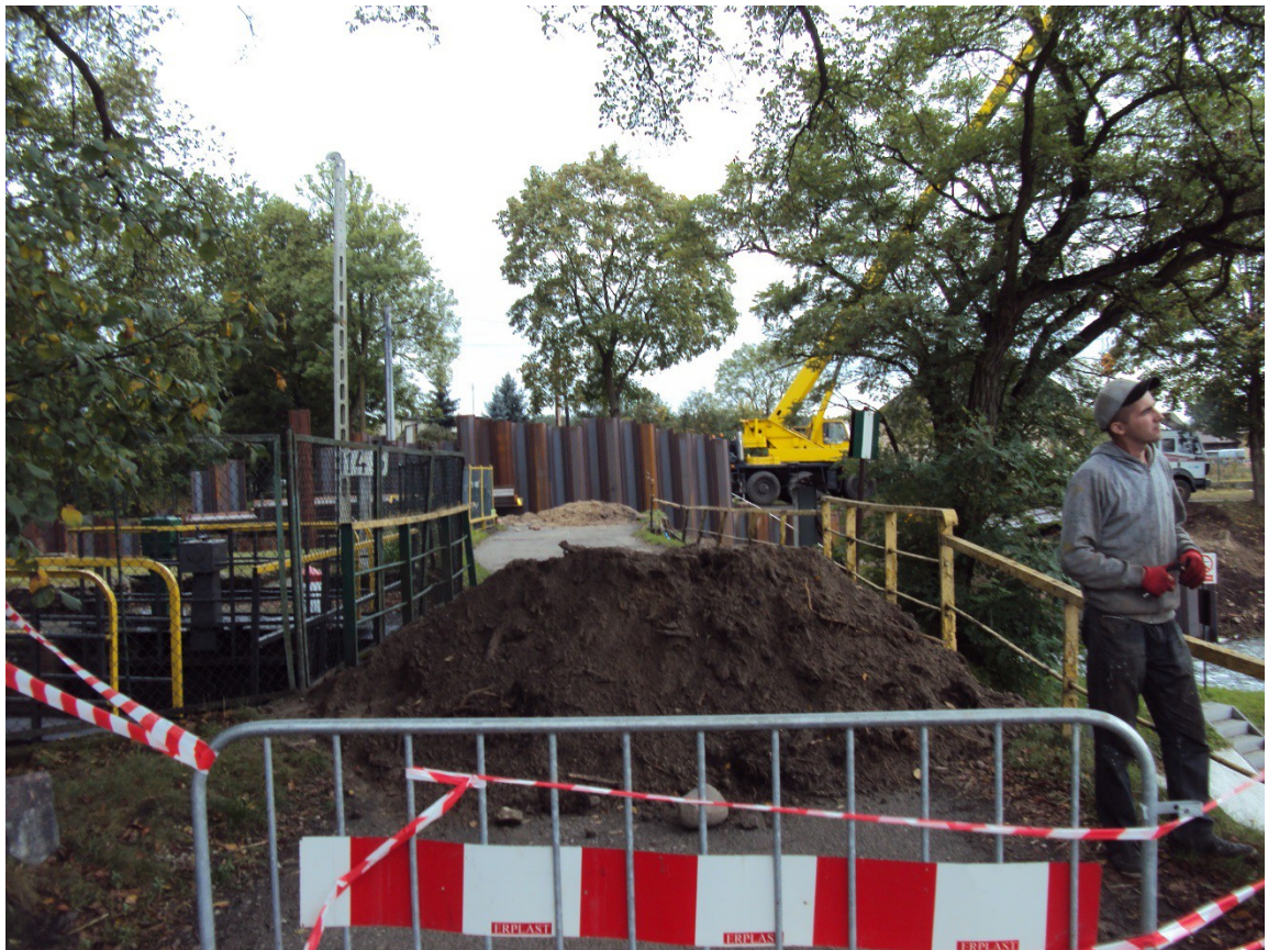
Łochowo zakończono wbijanie ścianki szczelnej
