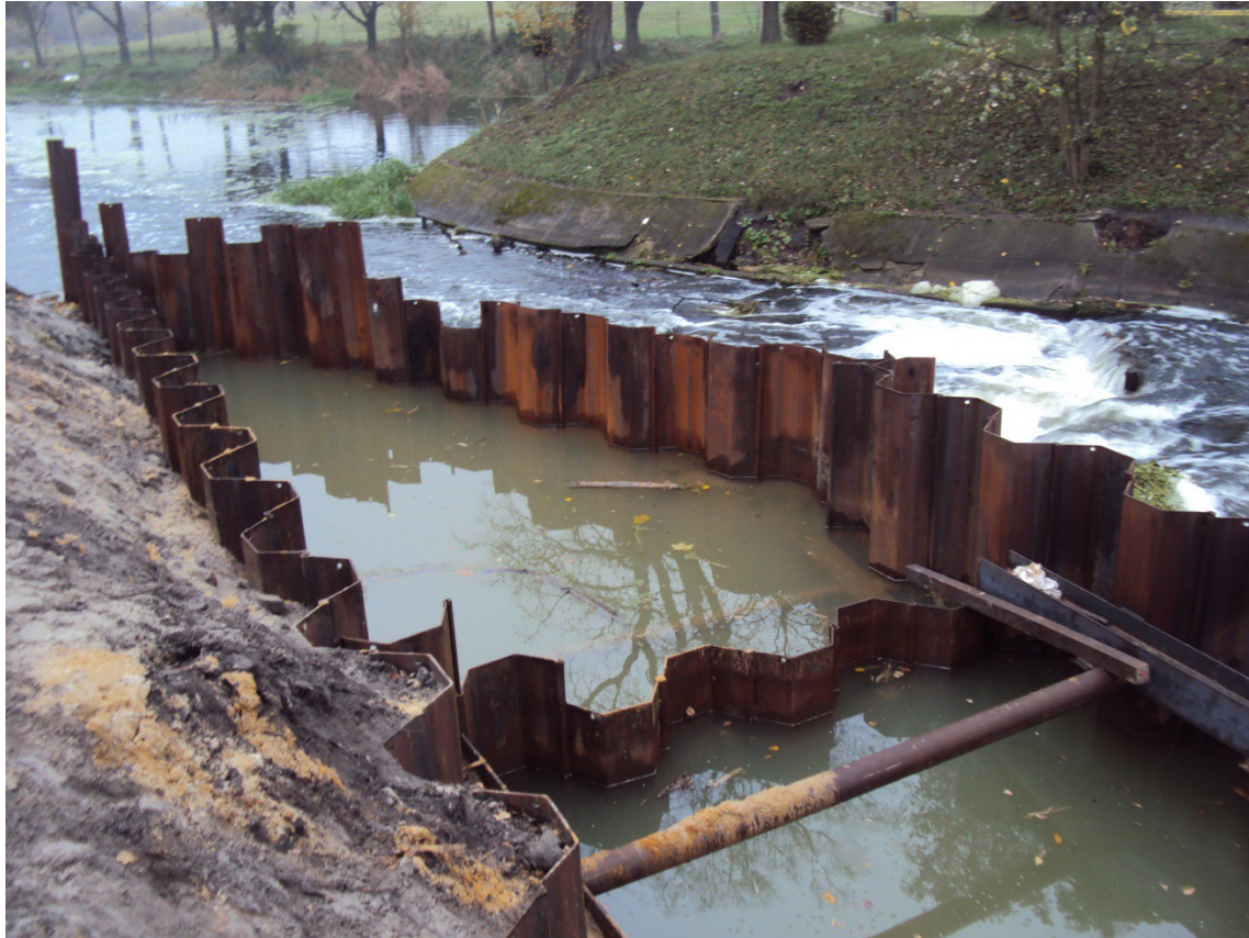
Lisi Ogon – zakończono wbijanie ścianki szczelnej przystąpiono do prac betoniarskich
